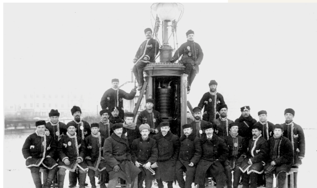
Электромонтеры петербургского общества электрического освещения «Гелиос»
